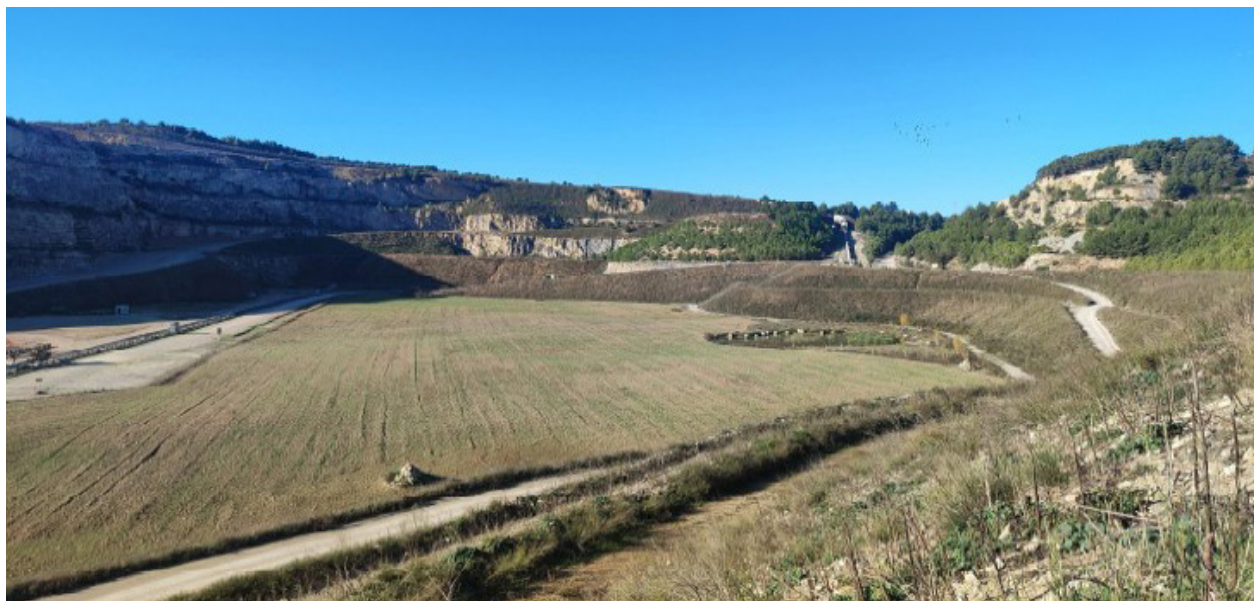
▼ Restauración de taludes y parcelas a cota 213 m con siembra naciente.
