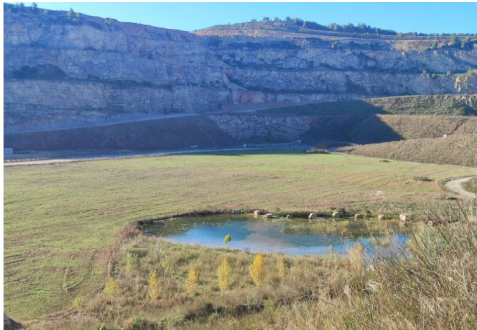
Bancos restaurados cota 253/233 m. Balsa de agua para aves y anfibios. Vista de la ampliación de Cantera. Crecimientos de cereales en parcela a la cota 213 m.
